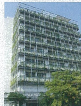
壁面緑化 建築学棟
